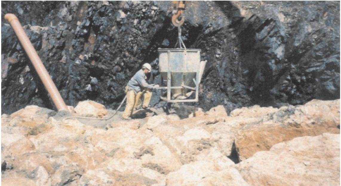
FIGURA 5.4. HORMIGONADO DE LA CIMENTACIÓN.
