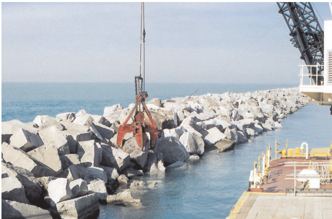
FIGURA 1.1. PUESTA EN OBRA DE ESCOLLERA EN UNA OBRA MARÍTIMA.
