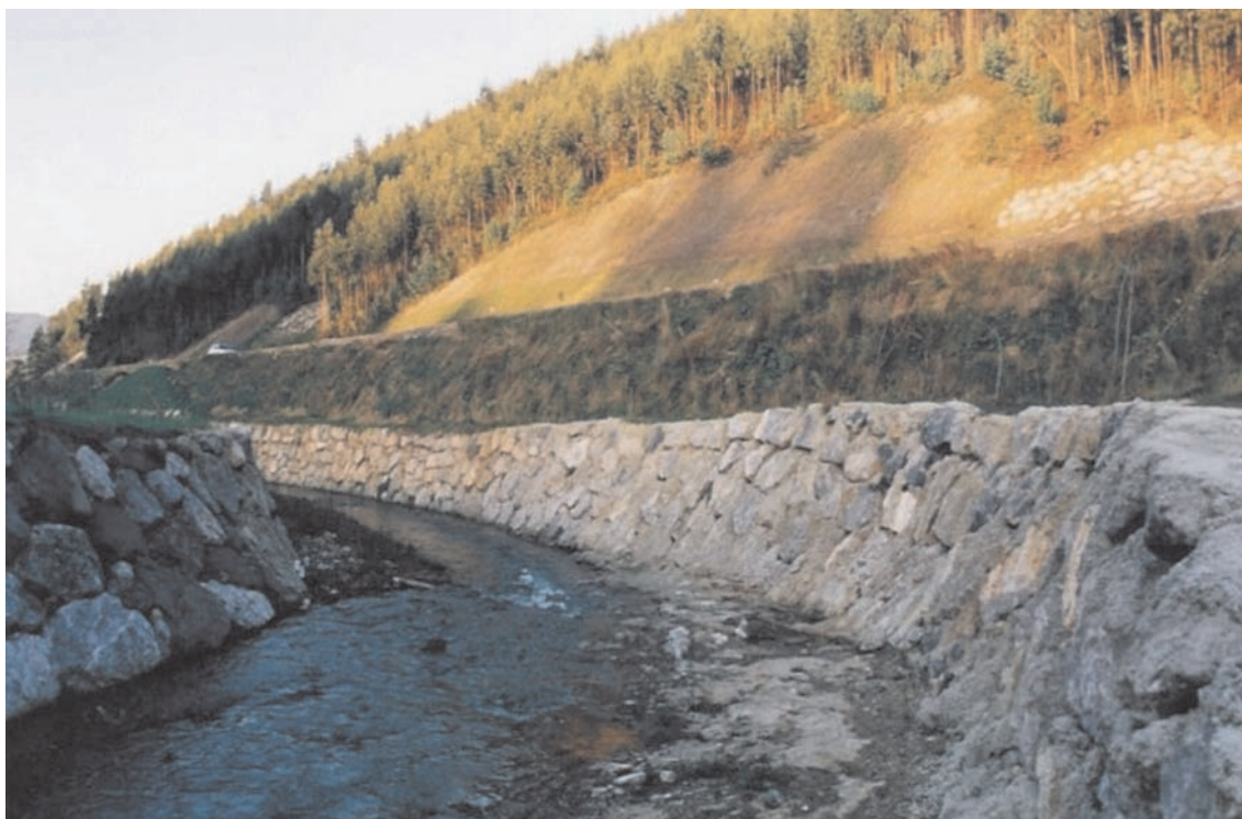
FIGURA 1.2. MURO DE ESCOLLERA EN UN ENCAUZAMIENTO FLUVIAL.
