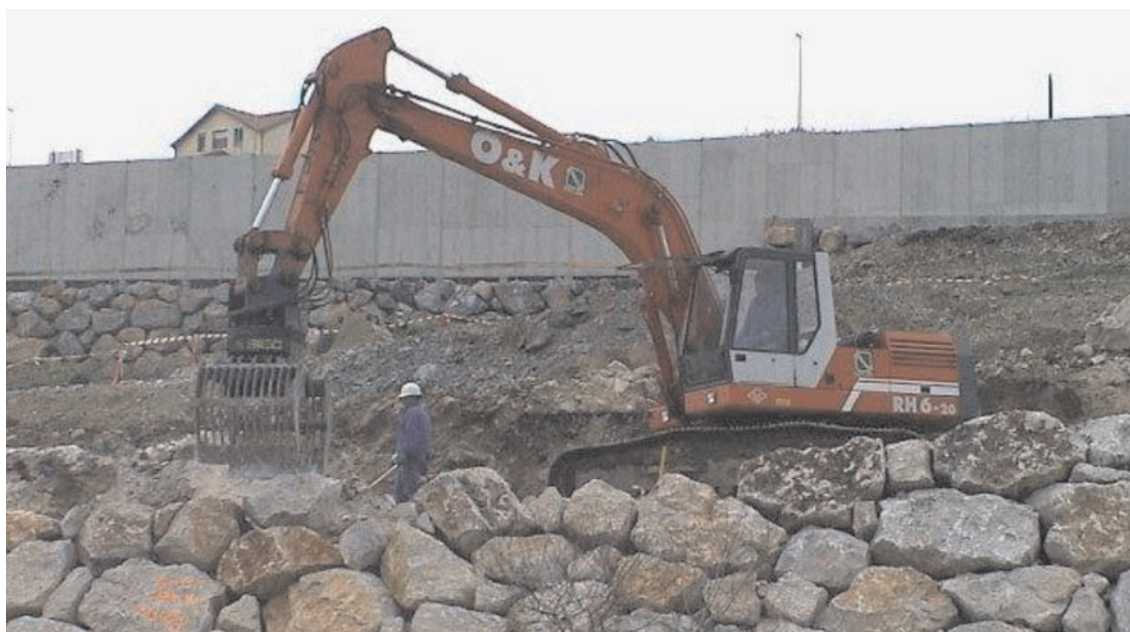
FIGURA 5.8. EJECUCIÓN MEDIANTE EXCAVADORA CON PINZA.
