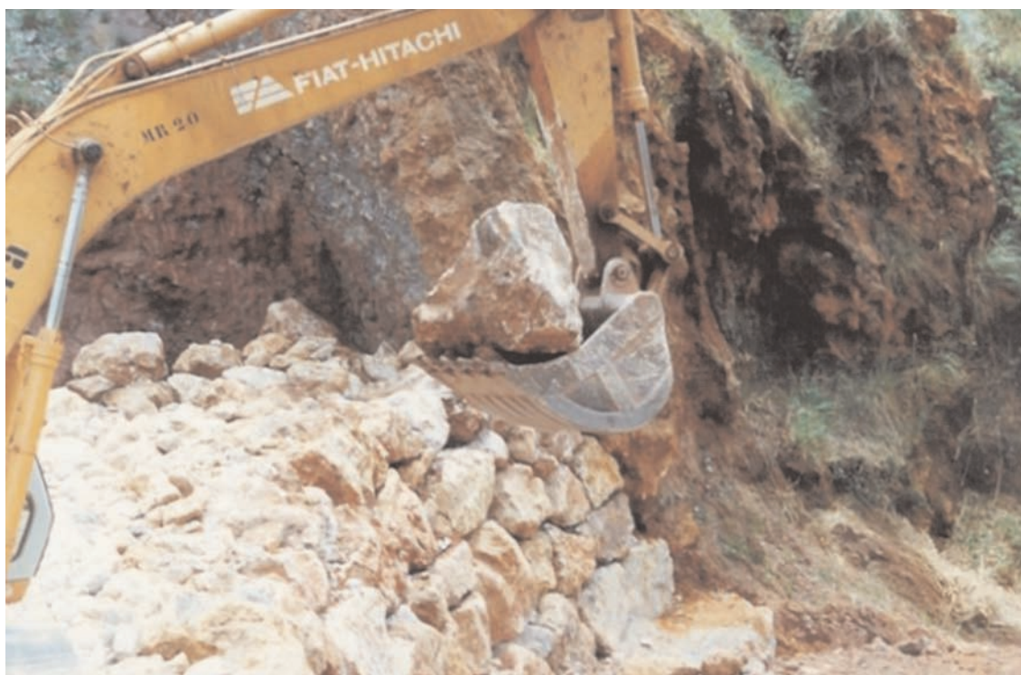
FIGURA A-1.1. EXCAVADORA CON CAZO.
