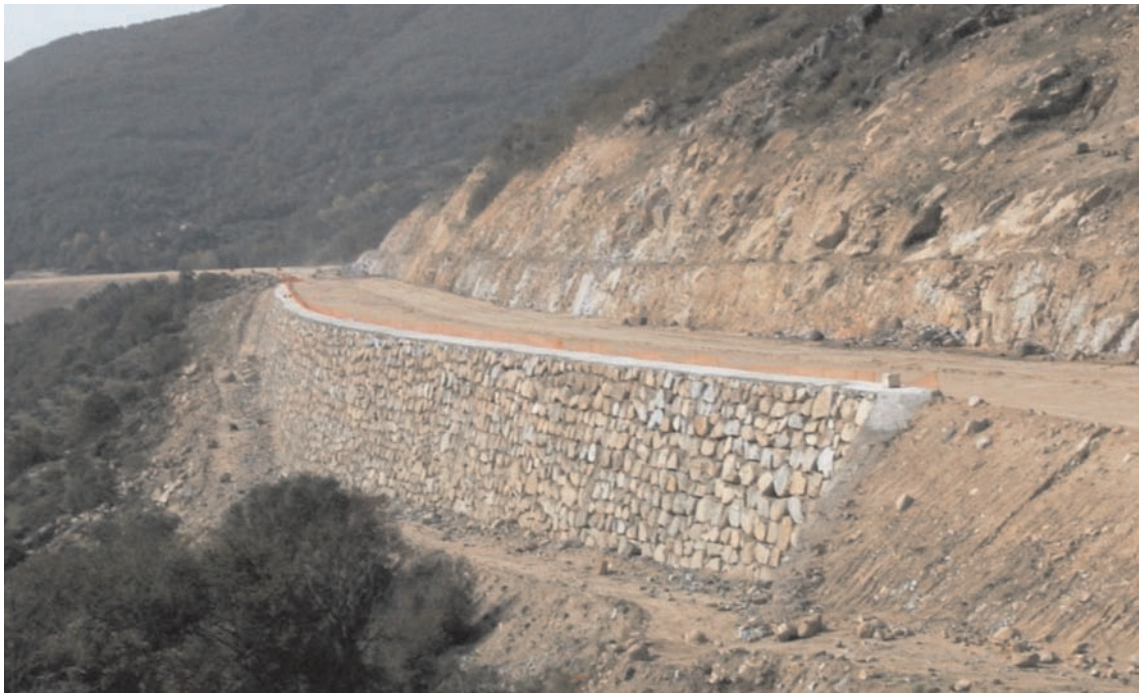
FIGURA 1.4. MURO DE SOSTENIMIENTO DE ESCOLLERA COLOCADA.
