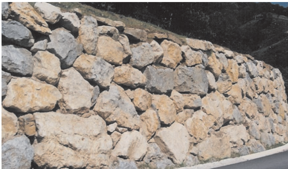
FIGURA 1.3. MURO DE CONTENCIÓN DE ESCOLLERA COLOCADA.
