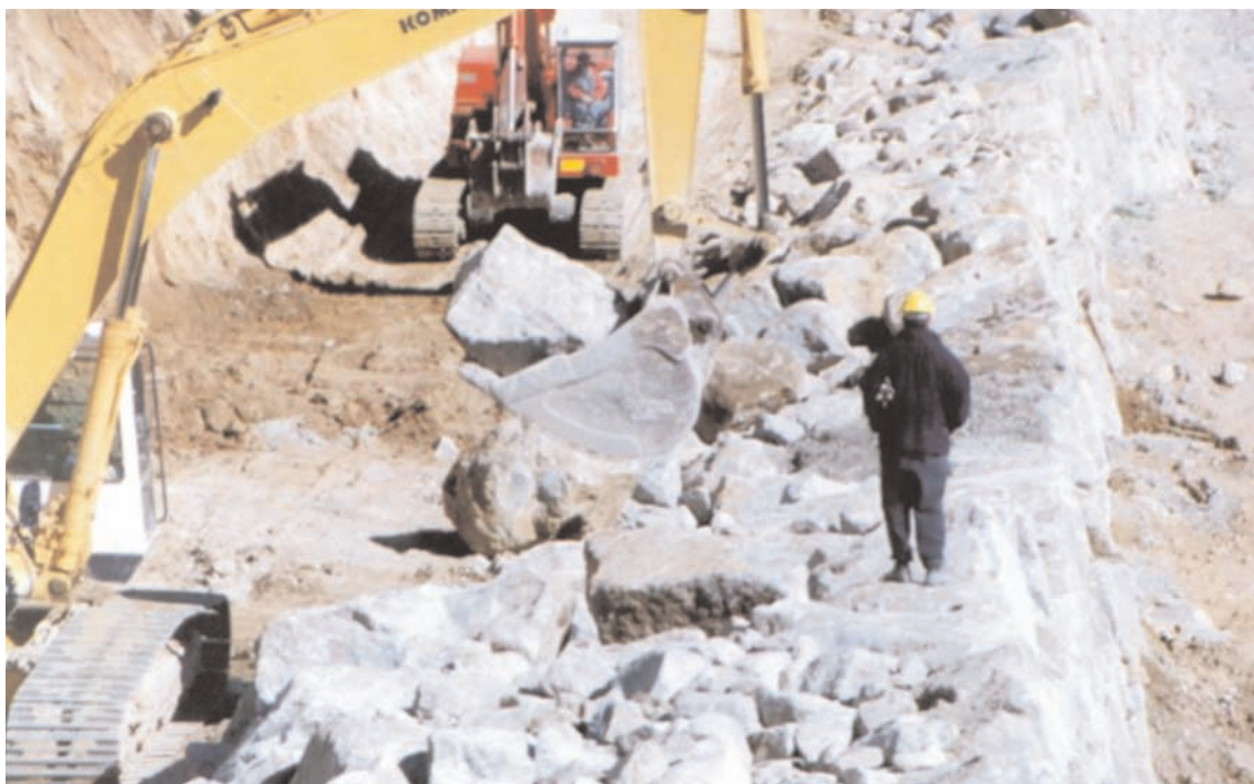
FIGURA 5.7. EJECUCIÓN MEDIANTE EXCAVADORA CON CAZO.
